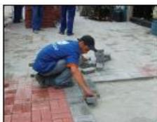
Colocação das peças de concreto, alinhamento, cortes e ajustes.
