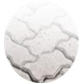
Pavimento de blocos pré-fabricados de concreto, assentados sobre camada de areia, travados através de contenção lateral e pelo atrito da camada de areia entre as peças.
