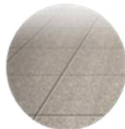
**Conforto térmico:** a utilização de placas com cores claras proporciona menor absorção de calor, melhorando o conforto térmico das calçadas.
