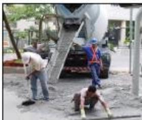
Lançamento, espalhamento e nivelamento (sarrafeamento) do concreto
