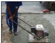
Instalação das contenções laterais, nivelamento e compactação da base.
