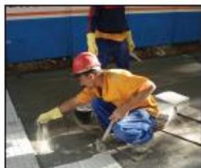
Aplicação de cimento pulverizado e água (etapa não necessária para argamassa colante).
