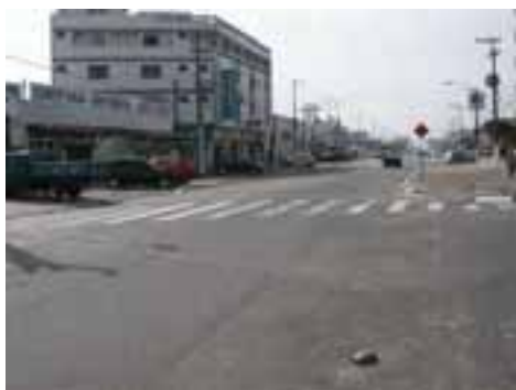
PGR10PON24FOT01 - Microdrenagem obstruída e insuficiente
