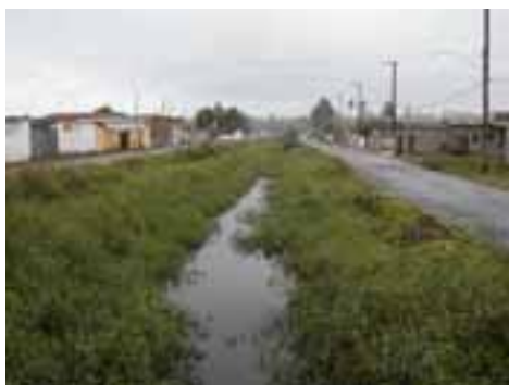
PGR15PON34FOT01 - Canal da Vila Sônia c/ as vias marginais
