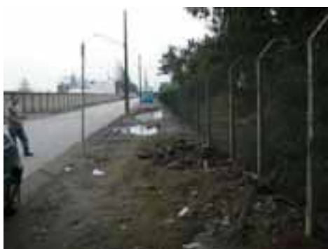
SAN01PON01FOT01 - Sistema de microdrenagem insuficiente e inadequado
