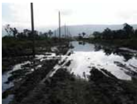
PGR04PON10FOT01 - Rua existente com pontos sérios de alagamento
