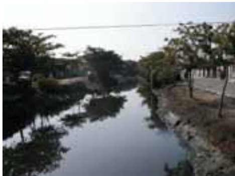
SAN09PON25FOT02 - Vala natural com viária na lateral assoreada
