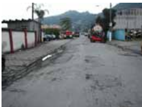
SVI10PON27FOT02 - Viário com microdrenagem recém implantada
