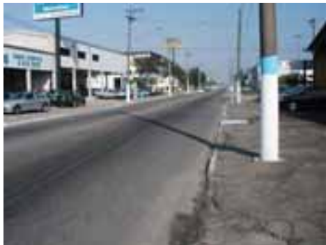
PGR29PON53FOT01 - Microdrenagem obstruída e insuficiente
