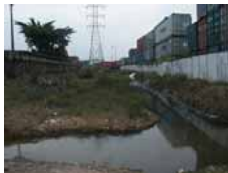
SAN02PON06FOT01 - Vala existente entre a área crítica SAN-01 e SAN-02
