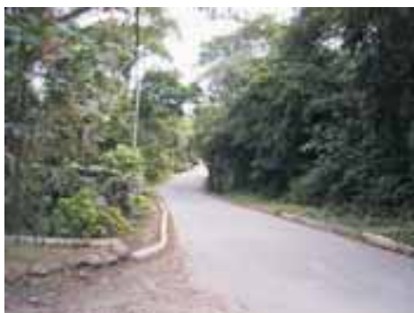
PER20PON44FOT01 - Vista típica de ponto da estrada do Guarau com estrangulamento na pista devido taludes em rocha (direita) e solo (esquerda).
