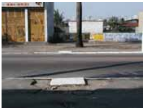
PGR29PON52FOT02 - Lançamento da microdrenagem
