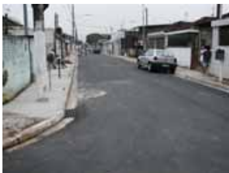
SAN08PON23FOT01 - Viário com microdrenagem recém implantada
