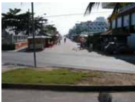
PGR09PON23FOT03 - Microdrenagem obstruída e insuficiente
