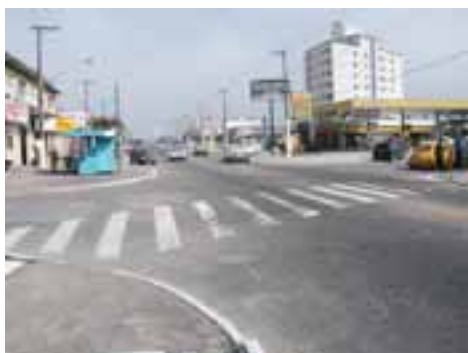
PGR10PON24FOT02 - Microdrenagem obstruída e insuficiente
