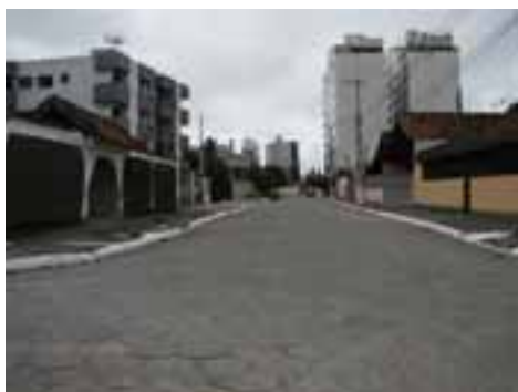
PGR20PON39FOT01 - Microdrenagem obstruída e insuficiente
