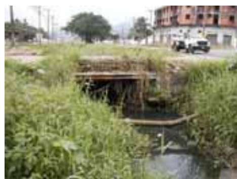
PGR28PON51FOT03 - Canal do Praião e travessia existente
