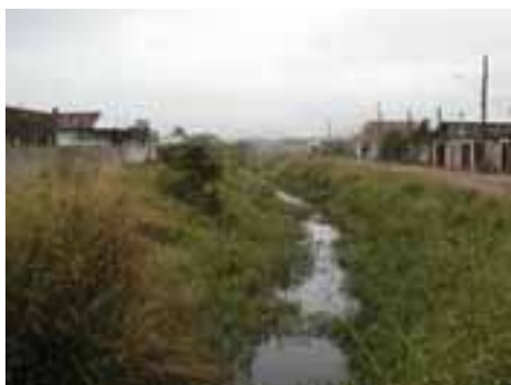
PGR15PON34FOT03 - Canal da Vila Sônia c/ ocupação na lateral
