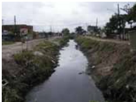
PGR07PON16FOT01 - Calha natural do rio Acaraú com vias marginais
