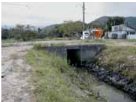
PGR04PON08FOT01 - Canalização existente
