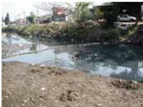
SAN09PON25FOT09 - Vala natural com viária na lateral assoreada
