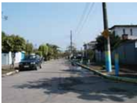
SAN03PON07FOT01 - Viário com microdrenagem insuficiente
