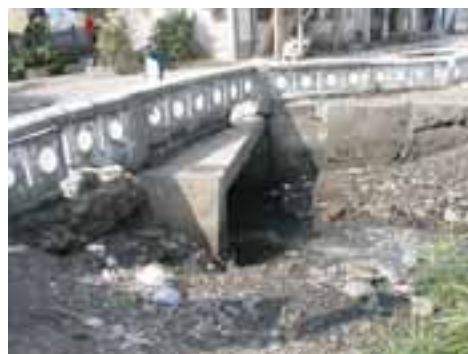
SAN04PON10FOT03 - Canal existente
