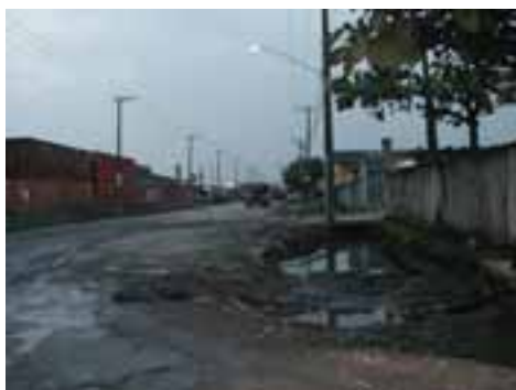
SAN02PON05FOT01 - Sistema de microdrenagem insuficiente e inadequado
