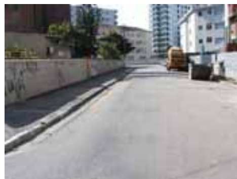
PGR30PON60FOT01 - Canal São Salvador sob a via
