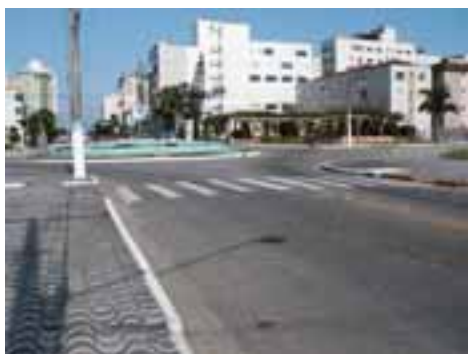
PGR30PON59FOT01 - Microdrenagem obstruída e assoreada
