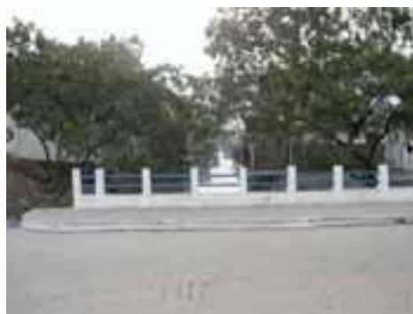
SAN06PON16FOT01 - Foz do canal da Av. Jovino Mello próximo aos diques
