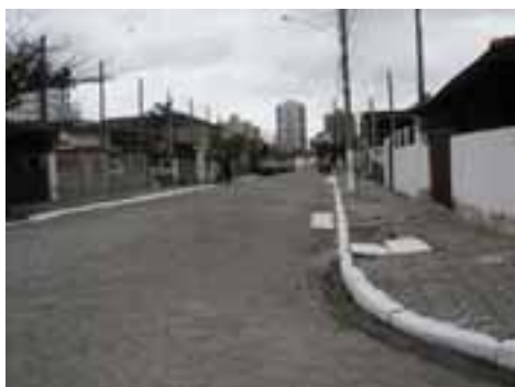
PGR18PON37FOT01 - Microdrenagem obstruída e insuficiente
