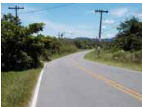
PER21PON49FOT01 - Inexistência de Microdrenagem no Ponto Baixo
