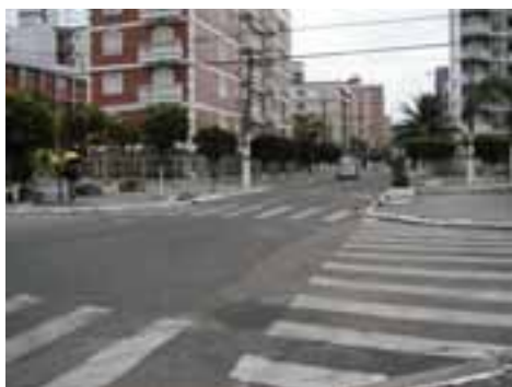
PGR13PON30FOT01 - Microdrenagem obstruída e assoreada
