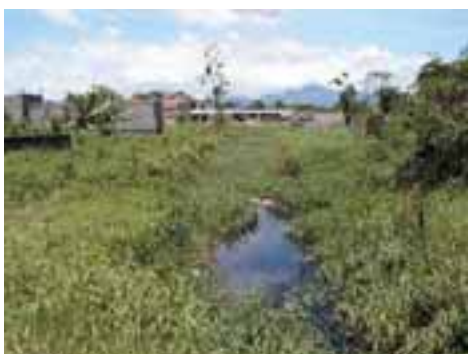
PER23PON54FOT02 - Canal Existente Assoreado e Insuficiente
