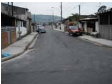
SAN08PON24FOT01 - Viário com microdrenagem recém implantada
