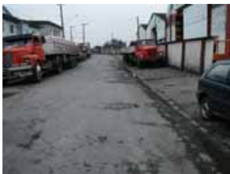
SVI10PON27FOT01 - Viário com microdrenagem recém implantada
