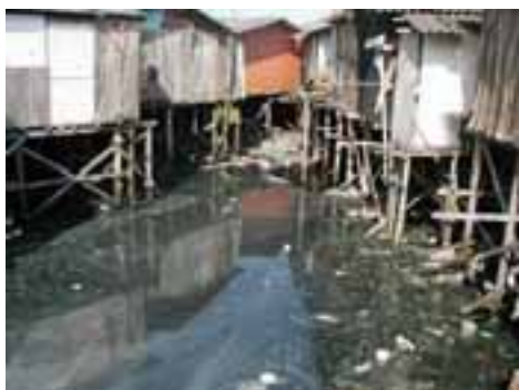
SAN07PON20FOT03 - Ocupações irregulares nos diques e mangues próximo a comporta existente
