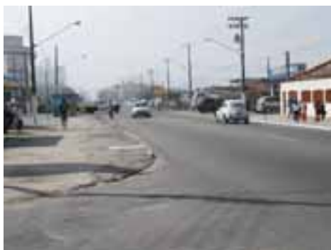
PGR11PON25FOT01 - Microdrenagem obstruída e insuficiente
