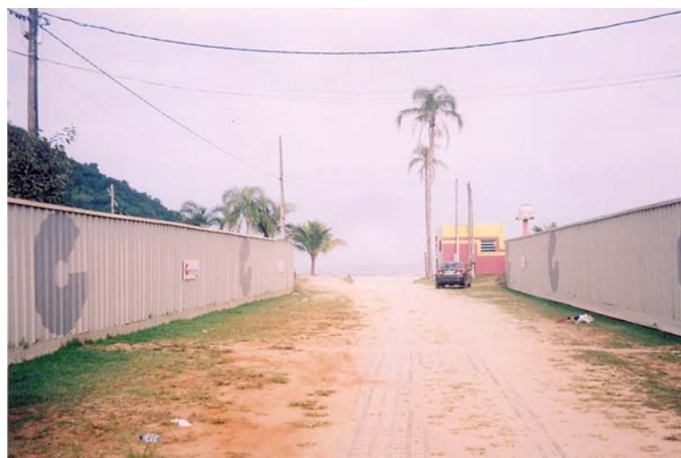
FOTO BER-21A MUNICÍPIO DE BERTIOGA (Julho de 2008) Praia de São Lourenço vista da Rua João Antunes Pinto, tendo-se a edificação do Corpo de Bombeiros ao lado dos dois coqueiros maiores, e os tapumes das obras de construção do Condomínio Península de São Lourenço, dos dois lados da via.
