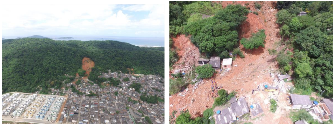
Figura 3 - Deslizamento ocorrido no Morro do Macaco Molhado - Guarujá, em 02 de março de 2020
