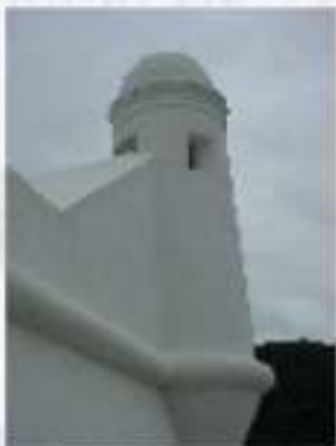
Detalhe de guarita de proteção
