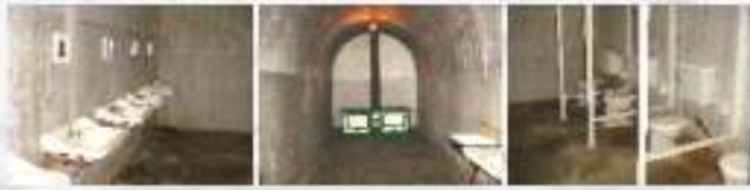
Instalações subterrâneas da Fortaleza dos Andradas
