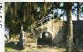
Escadaria de acesso
