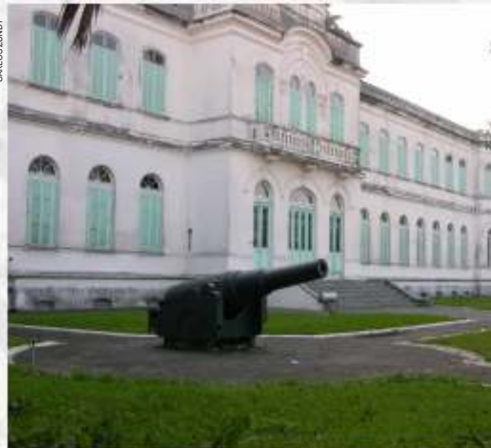
Canhão localizado no pátio da edificação, que atualmente sedia o Museu de Pesca de Santos
