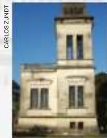
Instalações do Farol
