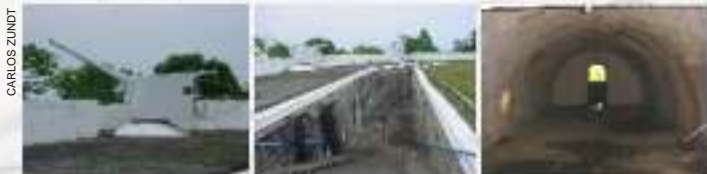
Canhão Schneider-Canet, rampa de acesso e dependências subterrânea no Forte Duque de Caxias
