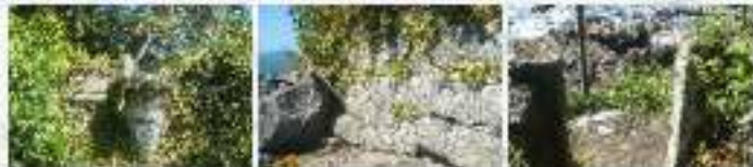
Detalhes das guaritas e muralha da fortificação.
