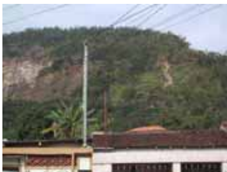
SVI86PON158FOT01 - Área de pedra desativada no Morro Voturuá.
