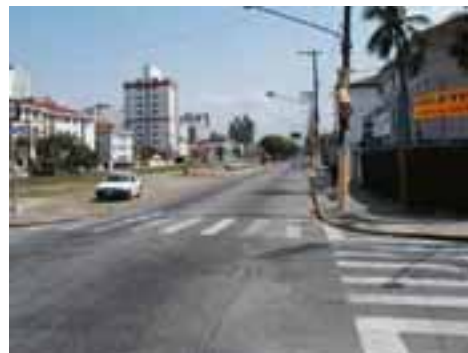
SVI98PON178FOT02 - Viário com microdrenagem insuficiente
