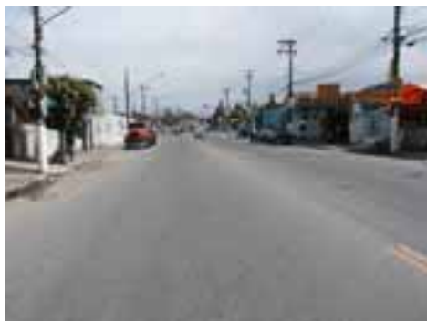
SVI96PON174FOT01 - Viário com microdrenagem insuficiente
