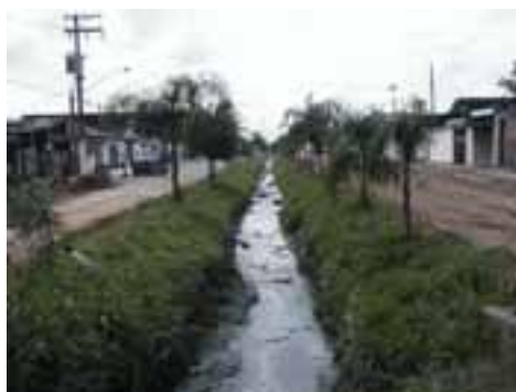
SVI91PON167FOT01 - Canal existente sem revestimento
