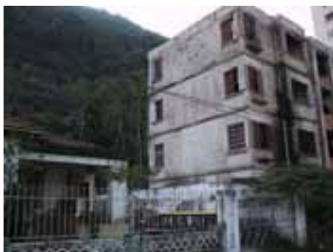
SVI87PON160FOT01 - Casa e edifício interditados devido a ocorrência de deslizamento do morro sobre a área de fundo daquelas edificações.
