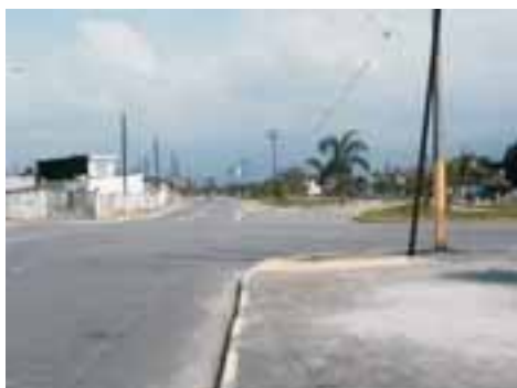
SVI92PON168FOT02 - Viário com microdrenagem recém implantada
