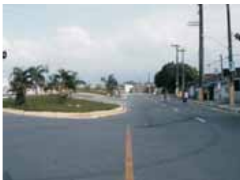
SVI92PON168FOT04 - Viário com microdrenagem recém implantada
