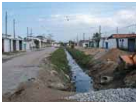
SVI91PON167FOT02 - Canal existente sem revestimento
