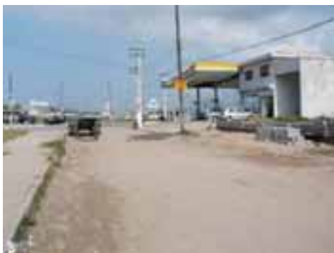
SVI89PON165FOT02 - Viário com microdrenagem insuficiente
