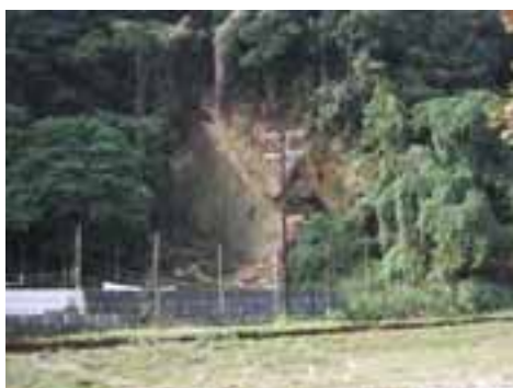
SVI87PON161FOT01 - Área do morro apresenta deslizamento recente da encosta.
