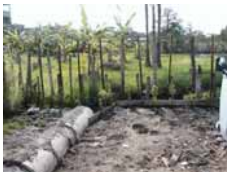
SVI90PON166FOT03 - Lançamento da vala próximo ao mangue
