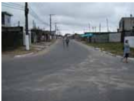
SVI06PON13FOT01 - Viário com microdrenagem recém implantada
