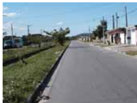
SVI12PON27FOT02 - Trecho em canal a céu aberto, assoreado
