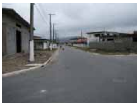
SVI05PON12FOT02 - Viário com microdrenagem recém implantada
