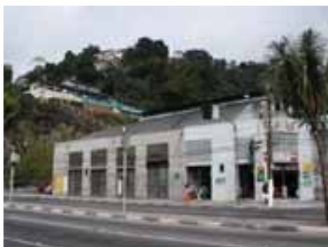
SAN26PON51FOT01 - Vista geral do Morro Boa Vista com áreas de risco de deslizamento de vias
