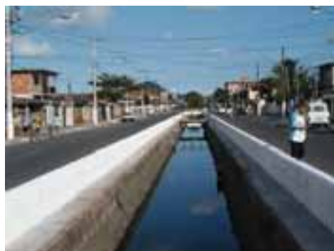
SVI26PON49FOT01 - Canal recém implantado
