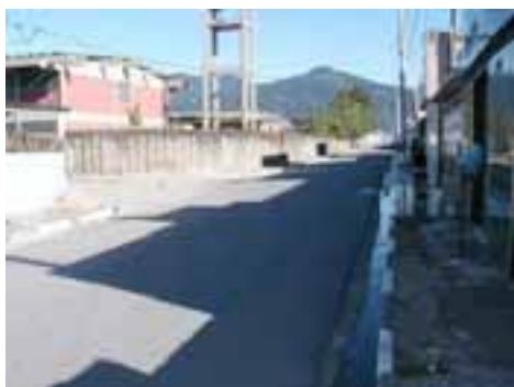
SVI17PON33FOT01 - Viário com microdrenagem inexistente
