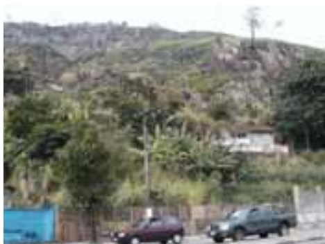
SAN23PON47FOT02 - Vista da encosta do Morro Caneleira com blocos de rocha apresentando risco de deslizamento sobre habitação e via.
