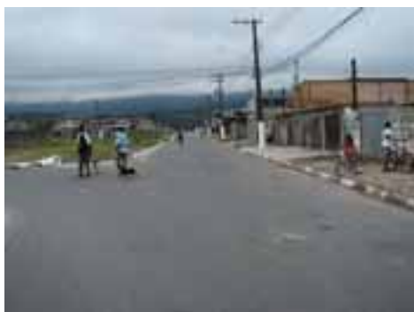
SVI06PON14FOT02 - Viário com microdrenagem recém implantada
