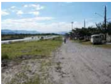
SVI07PON15FOT01 - Travessia na rodovia afeta a marginal
