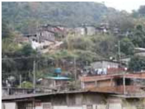
SAN22PON45FOT02 - Vista em detalhe da favela mostrando condições de risco das habitações locais.
