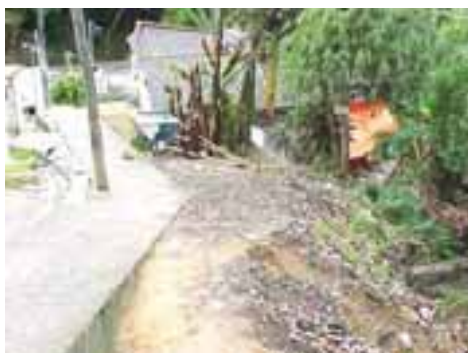
FOTO DA DEFESA CIVIL - Área de encosta com risco de deslizamento sobre habitação (Imagem extraída do relatório "Obras Defesa Civil 6 - PARTE 5").
