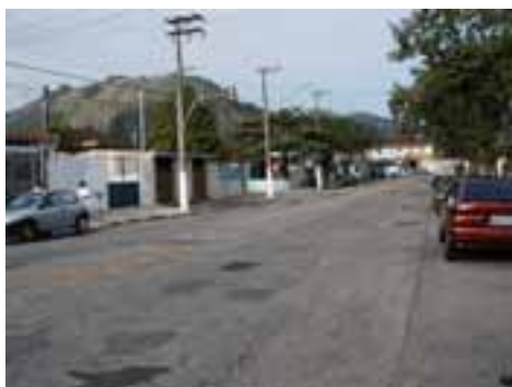
SAN15PON32FOT01 - Microdrenagem insuficiente e obstruída.
