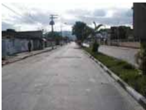
SVI25PON47FOT02 - Viário com microdrenagem assoreada e obstruída
