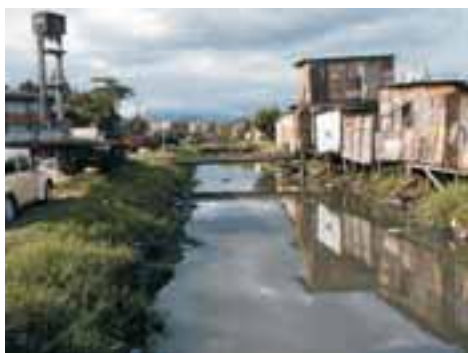
SVI24PON43FOT01 - Canal natural assoreado com travessia obstruída
