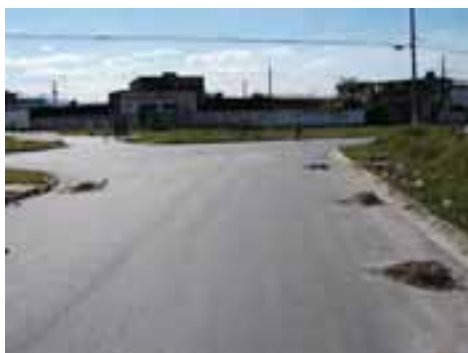
SVI18PON34FOT04 - Viário com microdrenagem recém implantada
