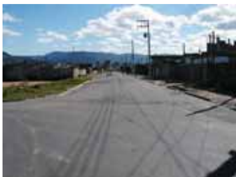
SVI20PON36FOT01 - Viário com microdrenagem recém implantada
