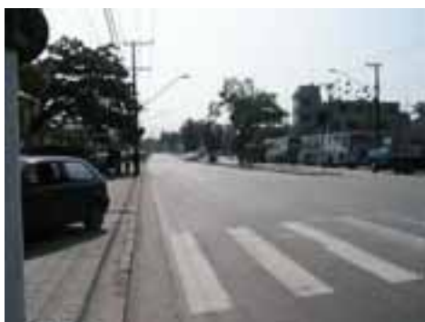
SAN14PON31FOT05 - Galeria de microdrenagem em reformulação
