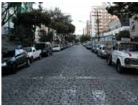
SAN32PON58FOT01 - Viário com microdrenagem e recém reformada
