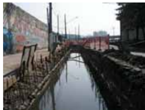
SAN13PON30FOT06 - Galeria de microdrenagem em ampliação
