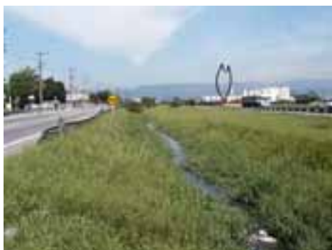
SAN41PON72FOT01 - Canal Lateral à Via Marginal
