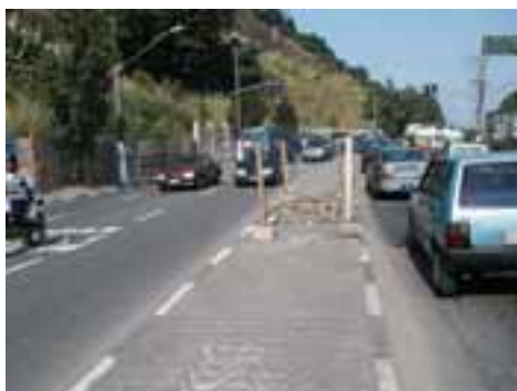
SAN14PON31FOT02 - Galeria de microdrenagem em reformulação
