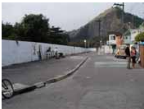
SAN16PON33FOT03 - Sistema de microdrenagem insuficiente e afetado pelo lançamento
