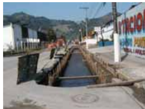
SAN13PON30FOT07 - Galeria de microdrenagem em ampliação
