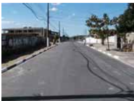
SVI13PON25FOT02- Viário com microdrenagem recém implantada
