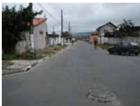
SVI05PON11FOT02 - Viário com microdrenagem recém implantada
