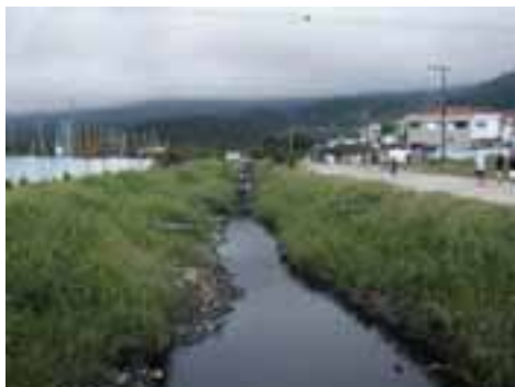
SVI01PON03FOT03 - Canal natural existente
