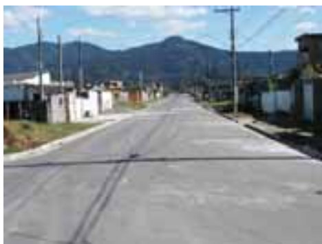
SVI18PON34FOT02 -Viário com microdrenagem recém implantada
