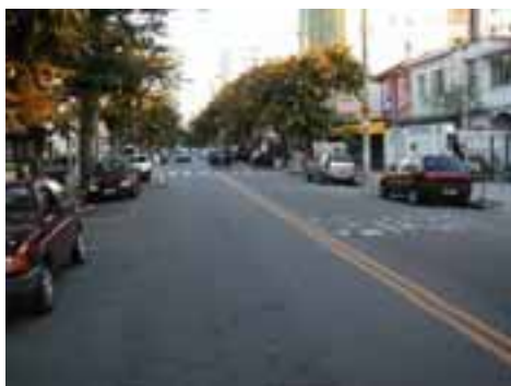
SAN31PON57FOT01 - Galeria existente insuficiente e caimento inadequado
