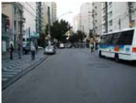
SAN33PON59FOT01 - Sistema de microdrenagem insuficiente e obstruído
