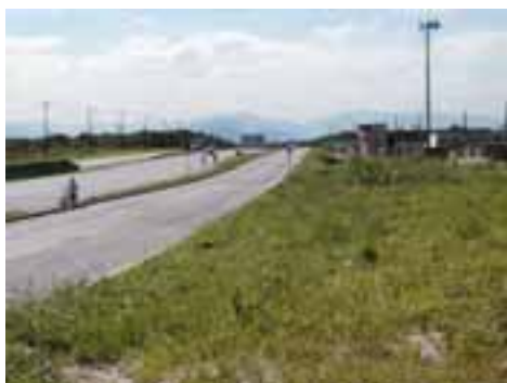
SVI07PON15FOT02 - Travessia na rodovia afeta a marginal
