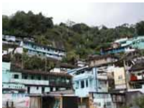
SAN25PON50FOT01 - Vista geral da encosta do Morro da Penha com áreas de risco de deslizamentos de blocos.
