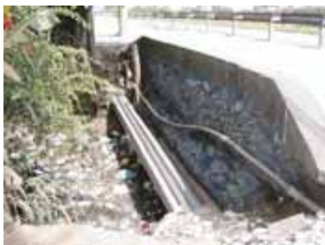
SAN41PON73FOT02 - Travessia Existente sob a Via Marginal
