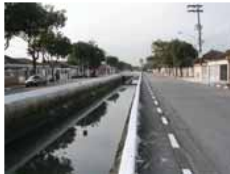
SAN11PON28FOT01 - Canal Trapezoidal existente.
