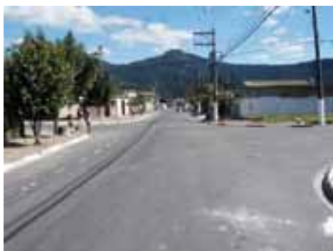
SVI13PON25FOT01- Viário com microdrenagem recém implantada
