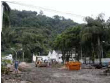
SAN27PO53FOT01 - Vista geral da área do Monte Serrat com vegetação preservada porém com blocos disseminados no meio da mata com risco de deslizamentos.
