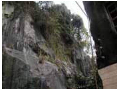
SAN28PON54FOT07 - Vista indicando a proximidade das instalações do Corpo de Bombeiros em relação a encosta do Monte Serrat.
