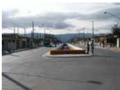
SVI26PON49FOT02 - Viário com microdrenagem existente
