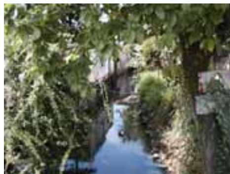
SAN41PON73FOT01 - Canal à Jusante da Travessia
