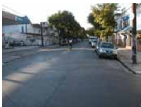
SAN38PON66FOT03 - Sistema de microdrenagem insuficiente e obstruído
