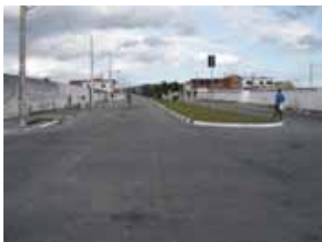
SVI23PON42FOT01 - Viário com galeria no canteiro central
