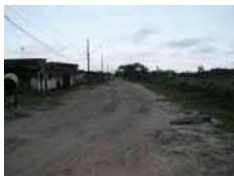
SVI01PON04FOT02 - Viário em terra sem microdrenagem
