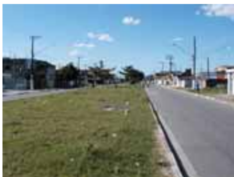
SVI12PON24FOT02 - Viário com galeria no canteiro central
