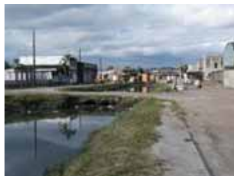
SVI24PON45FOT02 - Canal natural assoreado com travessia obstruída
