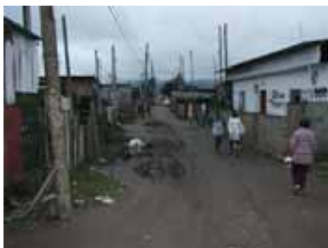
SVI03PON07FOT01 - Viário em terra sem microdrenagem
