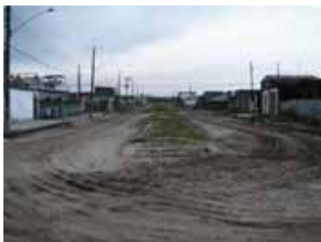
SVI02PON05FOT01 - Viário com pista dupla e sem microdrenagem
