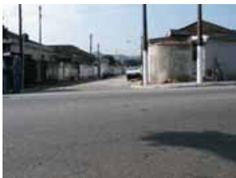
SAN12PON29FOT02 - Microdrenagem insuficiente e obstruída
