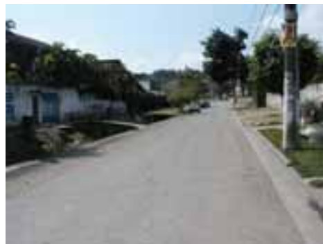
SAN40PON70FOT01 - Viário com microdrenagem insuficiente e assoreada
