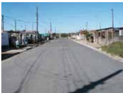
SVI20PON37FOT02 - Viário com microdrenagem recém implantada
