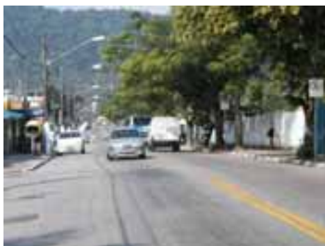
SAN12PON29FOT05 - Microdrenagem insuficiente e obstruída
