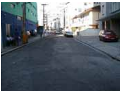
SAN35PON62FOT01 - Sistema de microdrenagem insuficiente e obstruído
