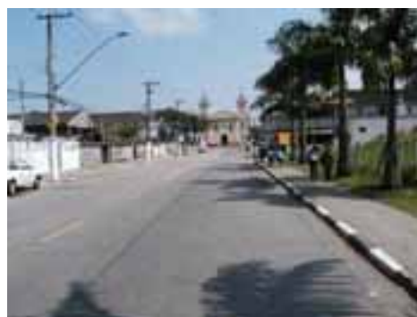
SAN40PON71FOT01 - Viário com microdrenagem insuficiente e assoreada
