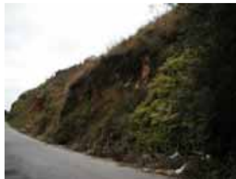
GUA06PON21FOT01 - Talude indicando cicatriz de deslizamento.
