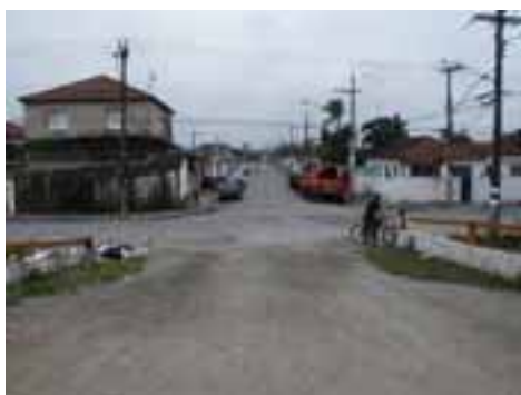
GUA39PON112FOT03 - Viário com microdrenagem insuficiente
