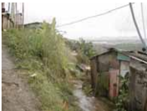
GUA08PON32FOT01 - Detalhe dos barracos em área de risco de deslizamento de encosta.
