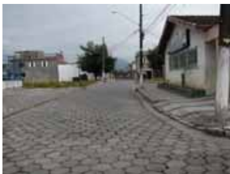
CUB18PON44FOT01 - Bairro com microdrenagem insuficiente e lançamento afetado pela maré
