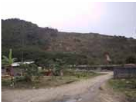
GUA23PON63FOT01 - Erosão da encosta do morro do Pitu em área de empréstimo desativada
