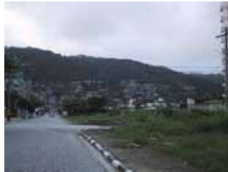
GUA14PON507FOT01 - Vista geral da ocupação na encosta do morro.
