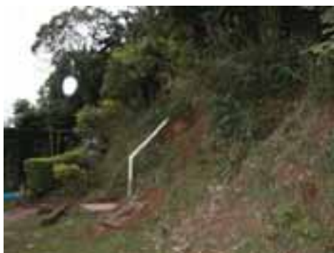
GUA18PON56FOT01 - Vista típica de talude na área de ocupação do morro.
