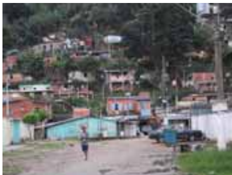
GUA14PON497FOT01 - Detalhe das ocupações na encosta do morro apresentando risco de deslizamento.
