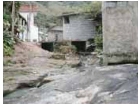
GUA08PON32FOT03 - Detalhe de casas construídas sobre a linha de drenagem natural do morro, observando afloramento rochoso na linha de drenagem.
