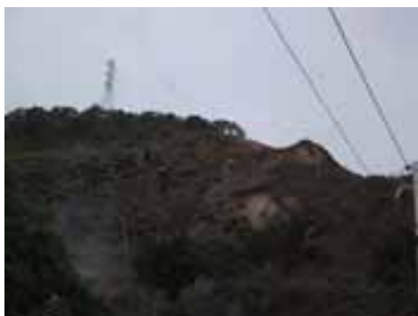
GUA26PON68FOT02 - Erosão da encosta do morro do Botelho. Observar torre de energia próximo à área de erosão
