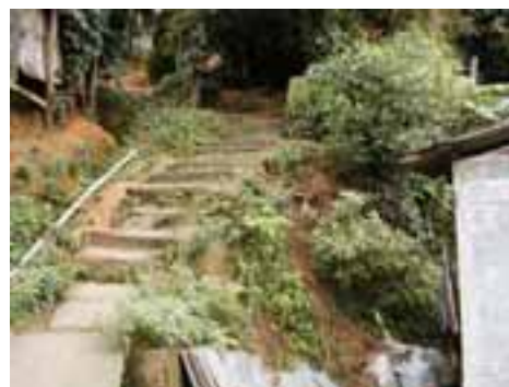
GUA08PON35FOT02 - Detalhe de barracos e escada em talude com risco de deslizamento.
