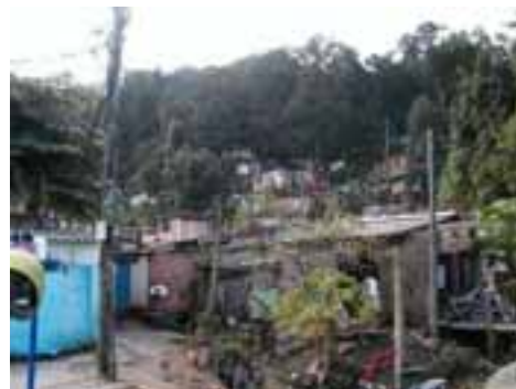
GUA12PON46FOT04 - Vista geral de ocupação mostrando barracos localizados no pé e na meia encosta do morro.
