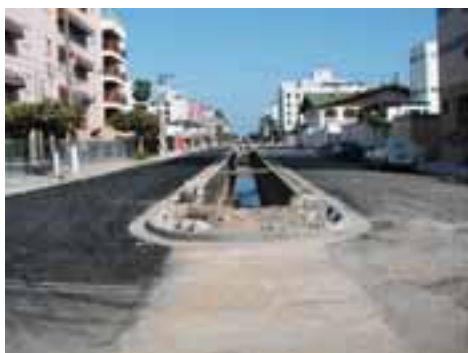
GUA51PON147FOT02 - Viário com microdrenagem recém implantada
