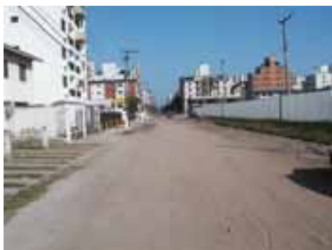
GUA52PON148FOT02 - Viário com microdrenagem recém implantada
