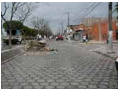
CUB18PON45FOT02 - Bairro com microdrenagem insuficiente e lançamento afetado pela maré
