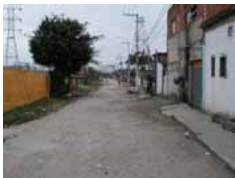
GUA40PON113FOT01 - Viário com microdrenagem insuficiente
