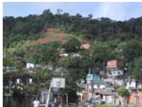
GUA11PON45FOT04 - Vista geral da ocupação da encosta no Jd. Bela Vista. Observar área de encosta com cicatriz de deslizamento ocorrido recentemente no topo do morro.
