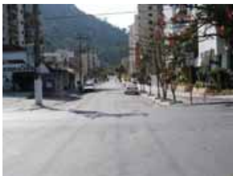
GUA49PON142FOT02 - Viário com microdrenagem insuficiente
