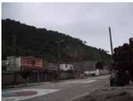
GUA25PON66FOT01 - Erosão da encosta do morro do Botelho em área de empréstimo desativada
