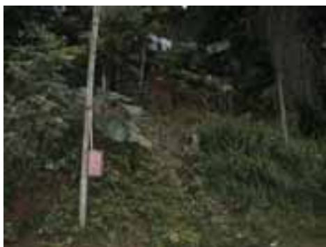
GUA18PON565FOT02 - Vista de barracos ocupado a meia encosta do morro com risco de deslizamento.
