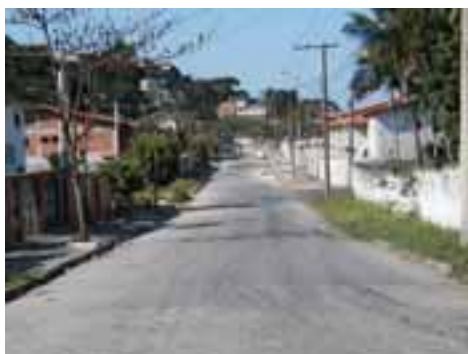
GUA50PON144FOT01 - Viário com microdrenagem insuficiente
