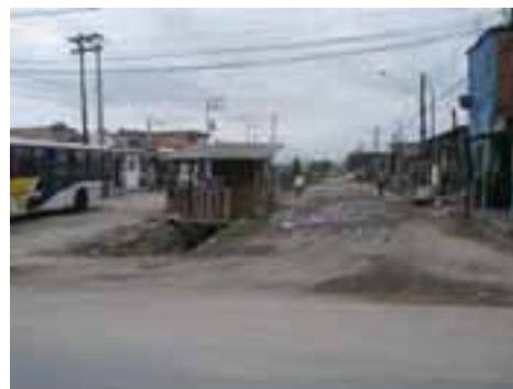
GUA47PON135FOT02 - Viário com microdrenagem inexistente
