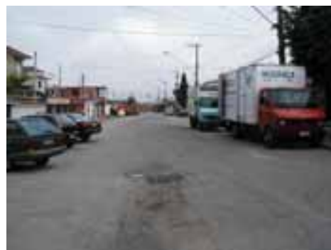
GUA42PON119FOT01 - Viário com microdrenagem insuficiente
