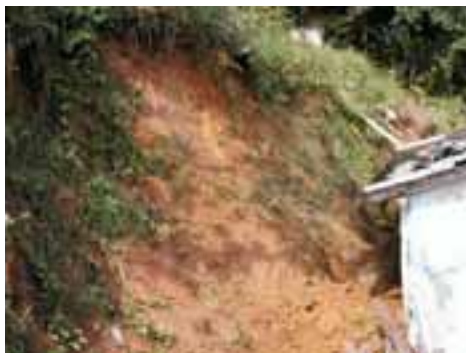
GUA09PON37FOT03 - Detalhe de barraco sobre talude de encosta.
