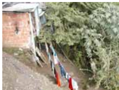
GUA05PON18FOT02 - Casa na meia encosta com risco de deslizamento.
