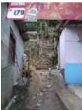
GUA15PON51FOT02 - Detalhe de viela e escada de acesso aos barracos do morro em condições de risco de deslizamento.
