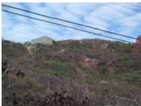
GUA34PON81FOT03 - Área de erosão de encosta do morro
