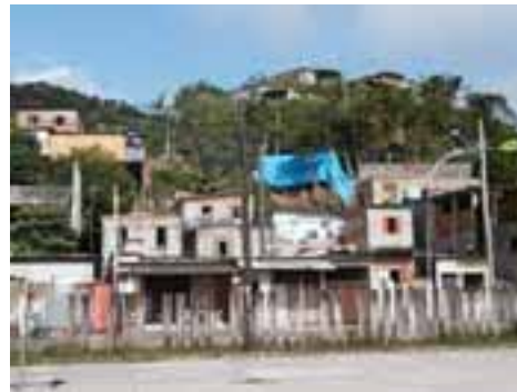
GUA11PON45FOT01 - Vista geral da ocupação da encosta e pé do morro.
