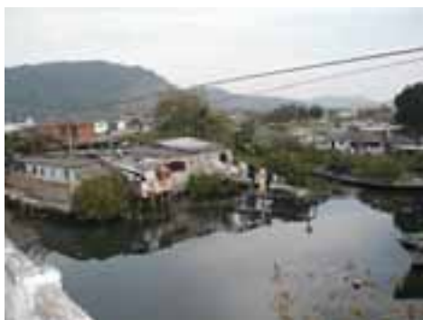
GUA02PON04FOT02 - Canal existente assoreado e obstruído
