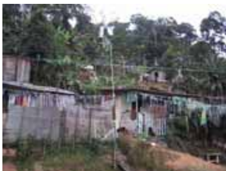
GUA15PON51FOT01 - Vista de barracos em área de risco de deslizamento do morro.
