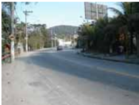
GUA04PON104FOT01 - Viário com microdrenagem insuficiente
