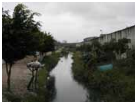
GUA01PON84FOT02 - Vala existente sem revestimento
