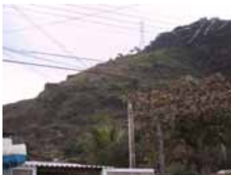
GUA26PON69FOT01 - Erosão da encosta do morro do Botelho. Observar torre de energia próximo à área de erosão
