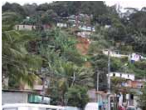
GUA14PON487FOT01 - Detalhe das ocupações em encosta do morro apresentando risco de deslizamento.
