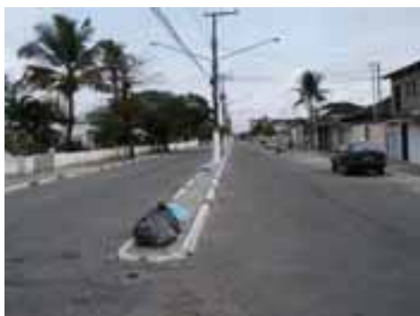
GUA37PON107FOT01 - Viário com microdrenagem insuficiente
