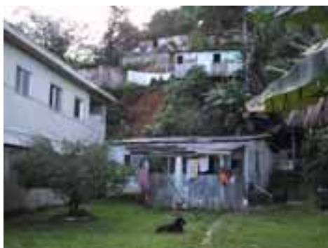
GUA13PON47FOT01 - Barracos existentes sobre talude com risco de deslizamento sobre casa.
