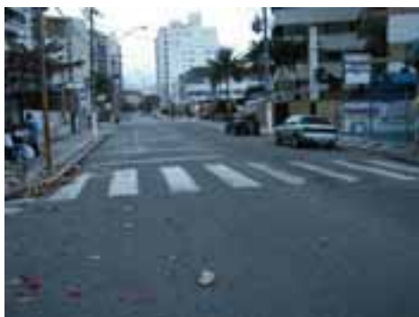
GUA36PON106FOT02 - Viário com microdrenagem insuficiente
