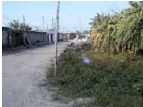
GUA53PON150FOT01 - Viário com microdrenagem inexistente
