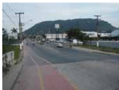
GUA02PON04FOT04 - Viário com microdrenagem insuficiente
