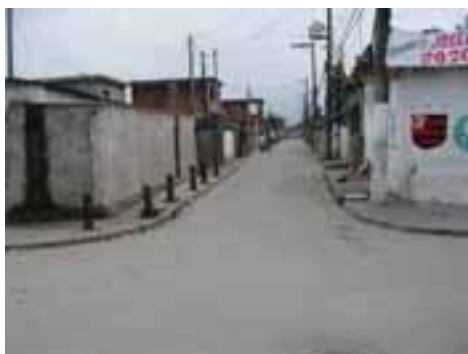
GUA41PON115FOT01 - Viário com microdrenagem insuficiente
