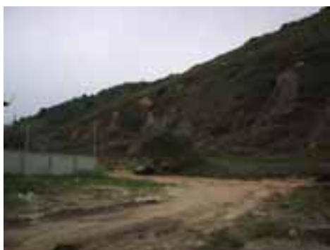
GUA21PON61FOT02 - Erosão na encosta do morro do Pinto em área de empréstimo desativada. Observar rua não pavimentada próxima da área de erosão
