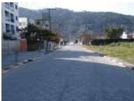
GUA51PON146FOT02 - Viário com microdrenagem recém implantada
