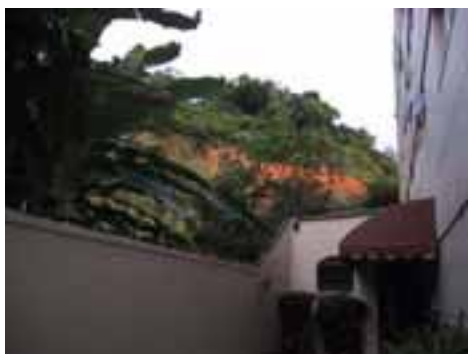
GUA32PON76FOT01 - Erosão / deslizamento de encosta do morro do Stefano localizado no fundo do terreno com edifício na rua Ciro Alves nº 105
