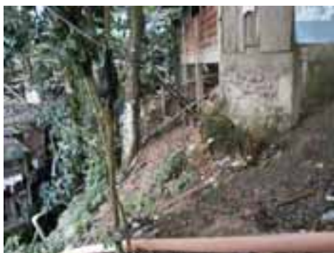
GUA12PON46FOT03 - Detalhe de barracos no pé e no topo de talude com risco de deslizamento.
