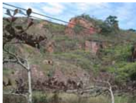
GUA34PON81FOT02 - Área de erosão próximo à caixa d'água
