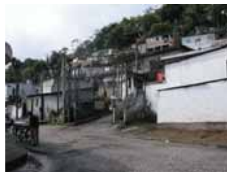
GUA09PON37FOT05 - Vista principal das ocupações de encosta na Vila Edna
