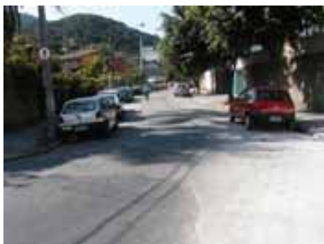
GUA46PON132FOT01 - Viário com microdrenagem insuficiente
