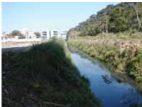
GUA48PON139FOT01 - Canal existente assoreado e obstruído
