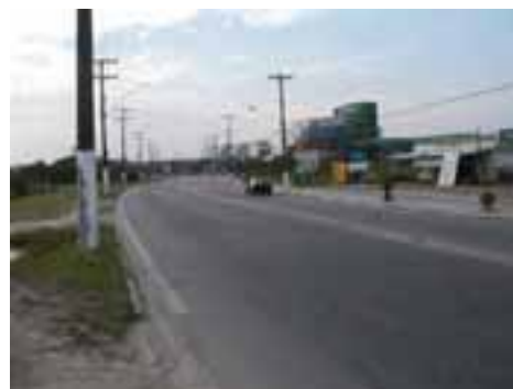
GUA02PON04FOT01 - Viário com microdrenagem insuficiente
