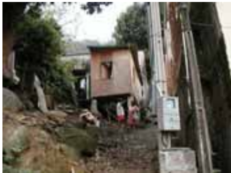
GUA07PON24FOT01 - Detalhe indicando a precariedade e insegurança das construções locais.
