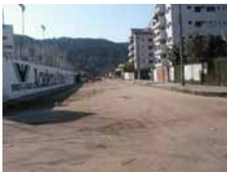
GUA52PON148FOT01 - Viário com microdrenagem recém implantada
