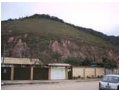
GUA21PON61FOT01 - Erosão na encosta do morro do Pinto em área de empréstimo desativada
