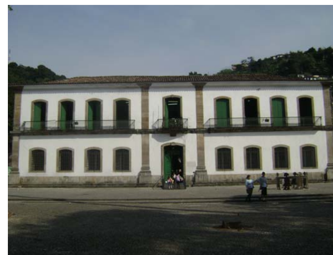
FOTO SAN-41 MUNICÍPIO DE SANTOS (Setembro de 2008) Foto da fachada principal da edificação tirada a partir da calçada da Praça dos Andradas
