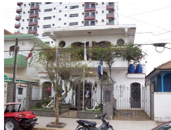
FOTO SAN-92 MUNICÍPIO DE SANTOS (Setembro de 2008) Foto da fachada do Atrativo, tirada a partir da Rua República do Equador
