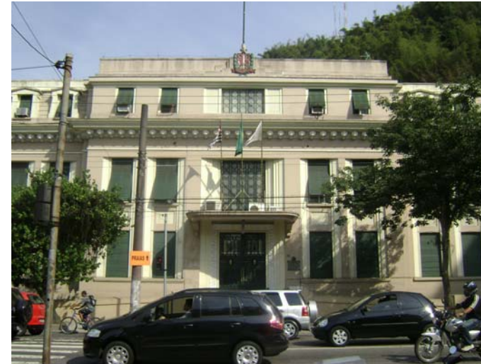
FOTO SAN-97 MUNICÍPIO DE SANTOS (Setembro de 2008) Foto da fachada do Atrativo, tirada a partir da Rua São Francisco
