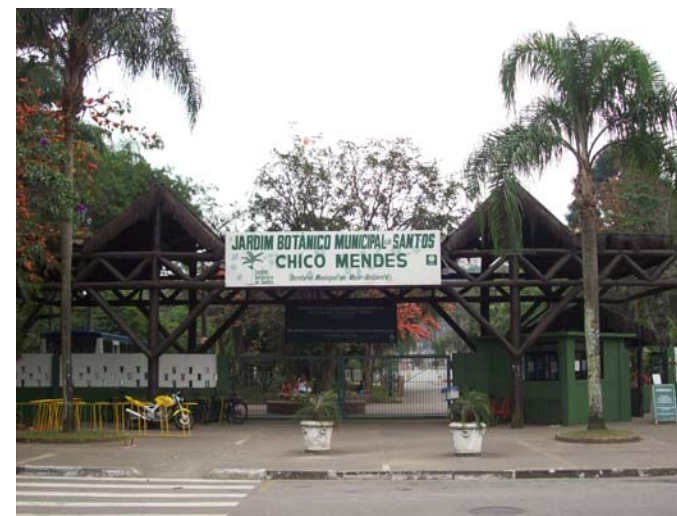
FOTO SAN-78 MUNICÍPIO DE SANTOS (Setembro de 2008) Foto da entrada do Atrativo, tirada a partir da Rua Engenheiro Antônio Freire
