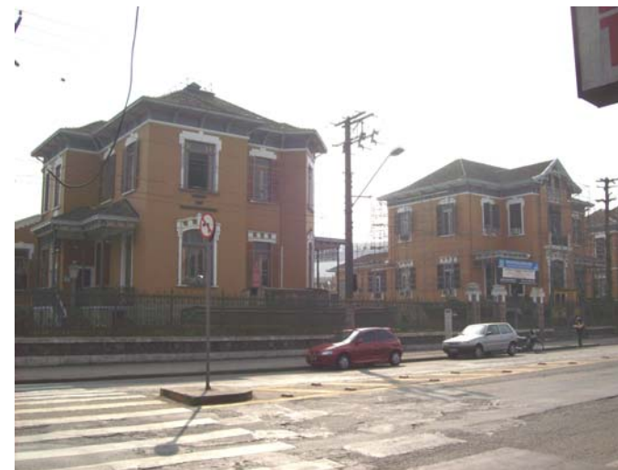
FOTO SAN-93 MUNICÍPIO DE SANTOS (Setembro de 2008) Foto da fachada do Atrativo, tirada a partir da Av. Rodrigues Alves
