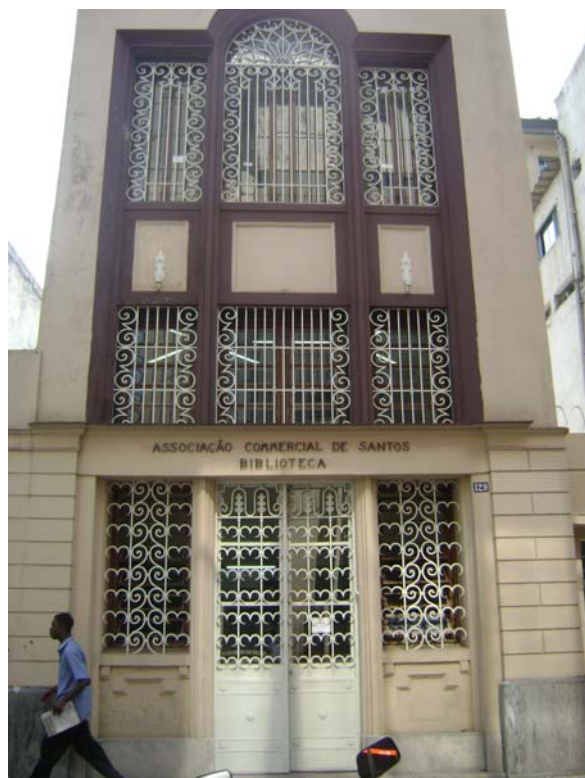
FOTO SAN-35 MUNICÍPIO DE SANTOS (Setembro de 2008) Vista da entrada da Biblioteca pela Rua Riachuelo, n° 129
