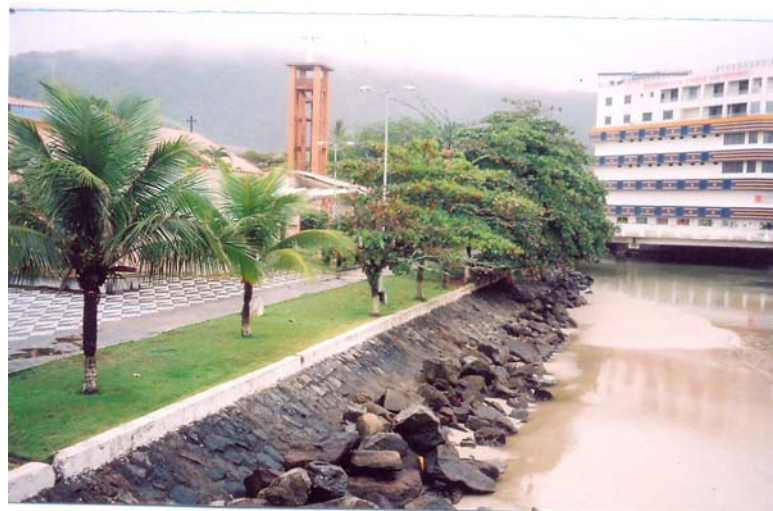
FOTO MON-25 (antiga Foto MON-22) MUNICÍPIO DE MONGAGUÁ (Julho de 2008) Margem esquerda do Rio Mongaguá junto à ponte da Av. São Paulo, na Área Central
