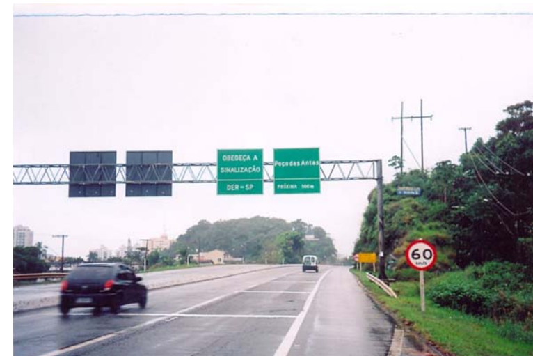
FOTO MON-02 MUNICÍPIO DE MONGAGUÁ (Agosto de 2008) Placa de sinalização de orientação instalada na pista norte da Rodovia Padre Manoel da Nóbrega – SP 55, junto ao Km 303 (Entroncamento da Rua Reinaldo Reis)
