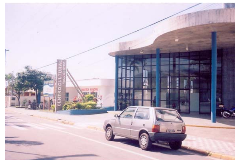
FOTO MON-06 MUNICÍPIO DE MONGAGUÁ (Julho de 2008) Vista da pista sul da Av. São Paulo, com o Centro Cultural Raul Cortez e a Biblioteca Municipal no centro da fotografia.
