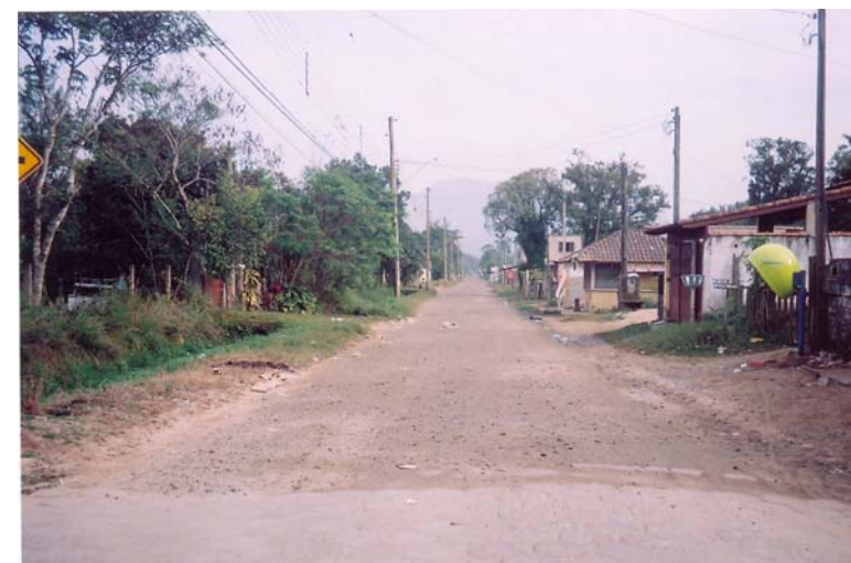
FOTO MON-15 MUNICÍPIO DE MONGAGUÁ (Agosto de 2008) Trecho da Estrada da Fazenda Barigui, a 300m da interseção da Rua Vera Cruz, no Jardim Primavera, onde termina a pavimentação asfáltica.
